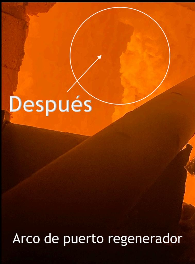
Debido a que la soldadura cerámica es un método de reparación en caliente, el trabajo de reparación del horno se puede realizar mientras el horno está caliente, no es necesario enfriar la superficie ni apagar el horno. La capacidad de realizar este proceso durante el funcionamiento normal del horno es un beneficio clave para nuestros clientes, ya que ayuda a eliminar la posible pérdida de producción.
