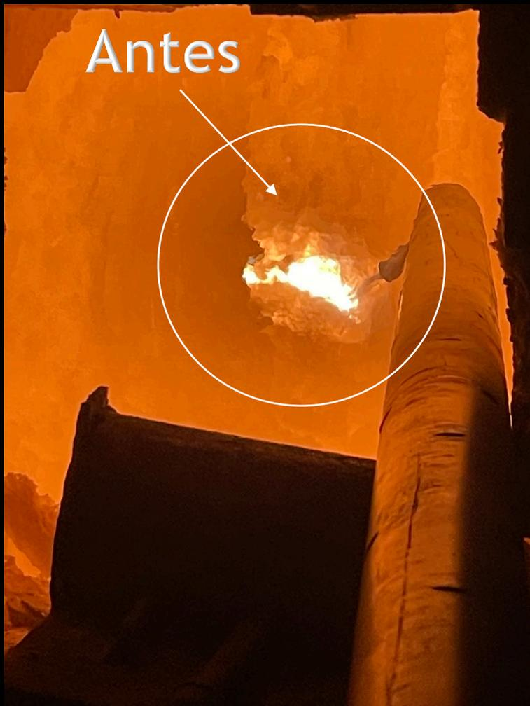
La soldadura cerámica es un método probado para realizar reparaciones en caliente de hornos industriales a temperaturas de funcionamiento.
