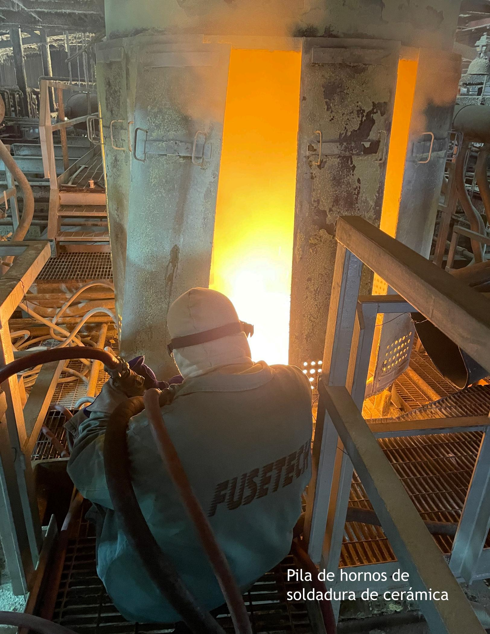
Pila de hornos de soldadura de cerámica
